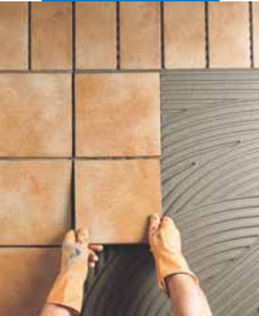
Ansetzen von Steinzeugfliesen im Außenbereich
